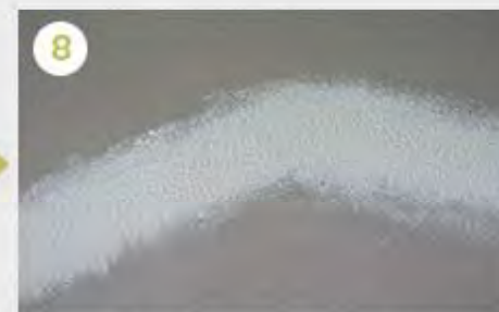
YGコートを砂骨ローラーで綺麗に塗布して完了 ここまでで、クラック処理TNC工法は完了です。(③~⑧までの工程は必ず当日施工として下さい。)
