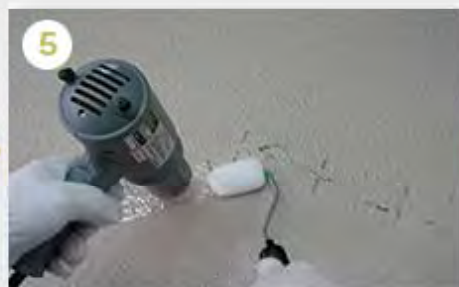
YGテープの貼付方向が変わる場合YGテープを1度カットして重ね貼りする。 (この時、重ね合うテープ部分へのプライマーは塗布しなくても良い) 後は、④と同じ要領で貼り付ける
