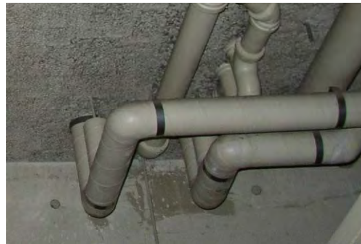
配管類の保温材
