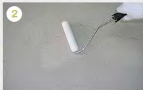
ウールローラーにてYGプライマーを塗布する
