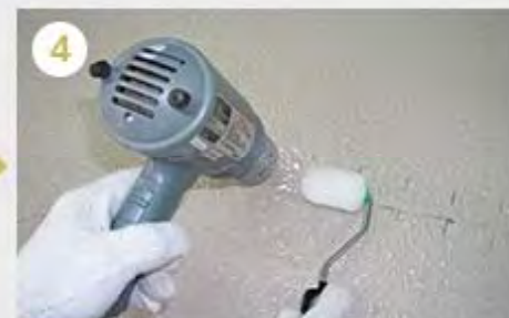
ヒーティングガンを用い、熱風をYGテープに当てて柔軟にし直ちに専用ローラーで、前後左右に転がし既存の柄(テクスチャー)に馴染ませて貼り付ける
