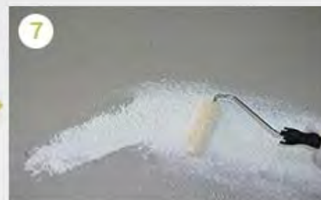
YGコートを砂骨ローラーでYGテープの上から塗布し始め、YGテープ上を厚めに塗布し外側に行くに従って徐々に塗厚を少なくして行く
