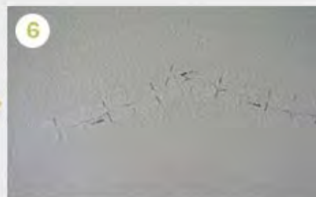
YGテープ貼り終わり状況 YGテープの特徴 YGテープは初期接着力は弱めに設定してあります。その理由は、接着力が高すぎると凸部に強く接着し、ローラーで押さえ込んでも凹部にテープが引っ張られない為、うまく馴染ませることが出来ません。したがって、YGテープに熱風を当てて柔軟にし、直ちに専用ローラーで前後左右に転がし、既存の柄(テクスチャー)に馴染ませて貼り付けることが出来るのです。その後、YGテープの粘着層が24時間経過後、時間を増すごとに粘着力が非常に強くなり2-3日後には十分な接着力が得られます。以上がYGテープの特徴となります。
