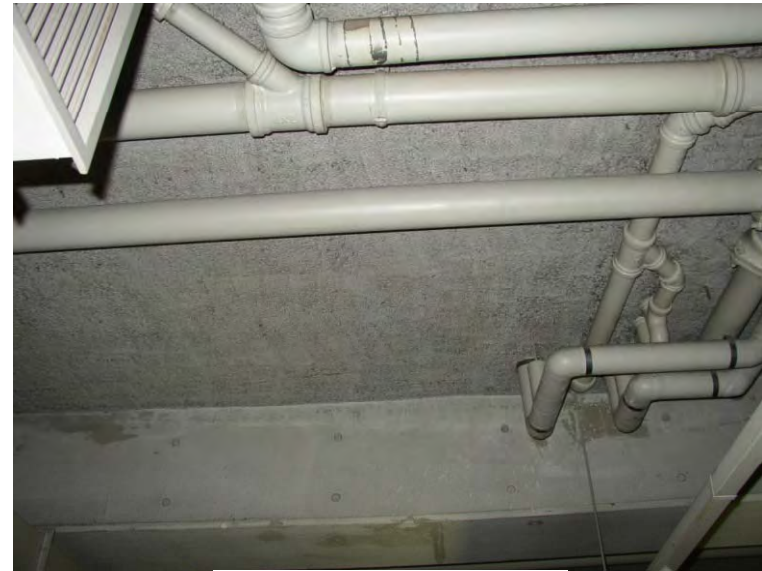
機械室の吹付材
