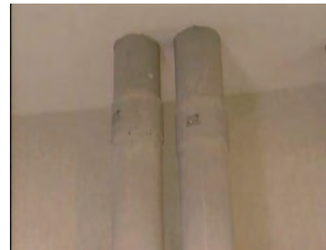
排水管などの耐火二層管
