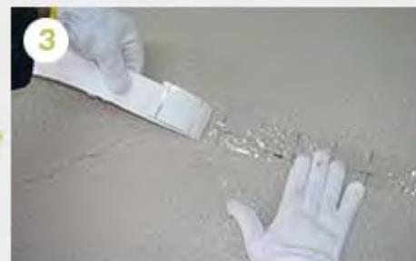
YGプライマー乾燥後離型紙を剥がしながらクラックがテープ内に納まる様貼って行く
